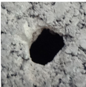
Отвір після свердління звичайним буром
