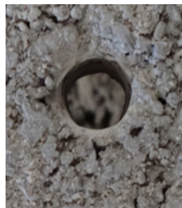
Отвір після свердління спеціалізованим буром
